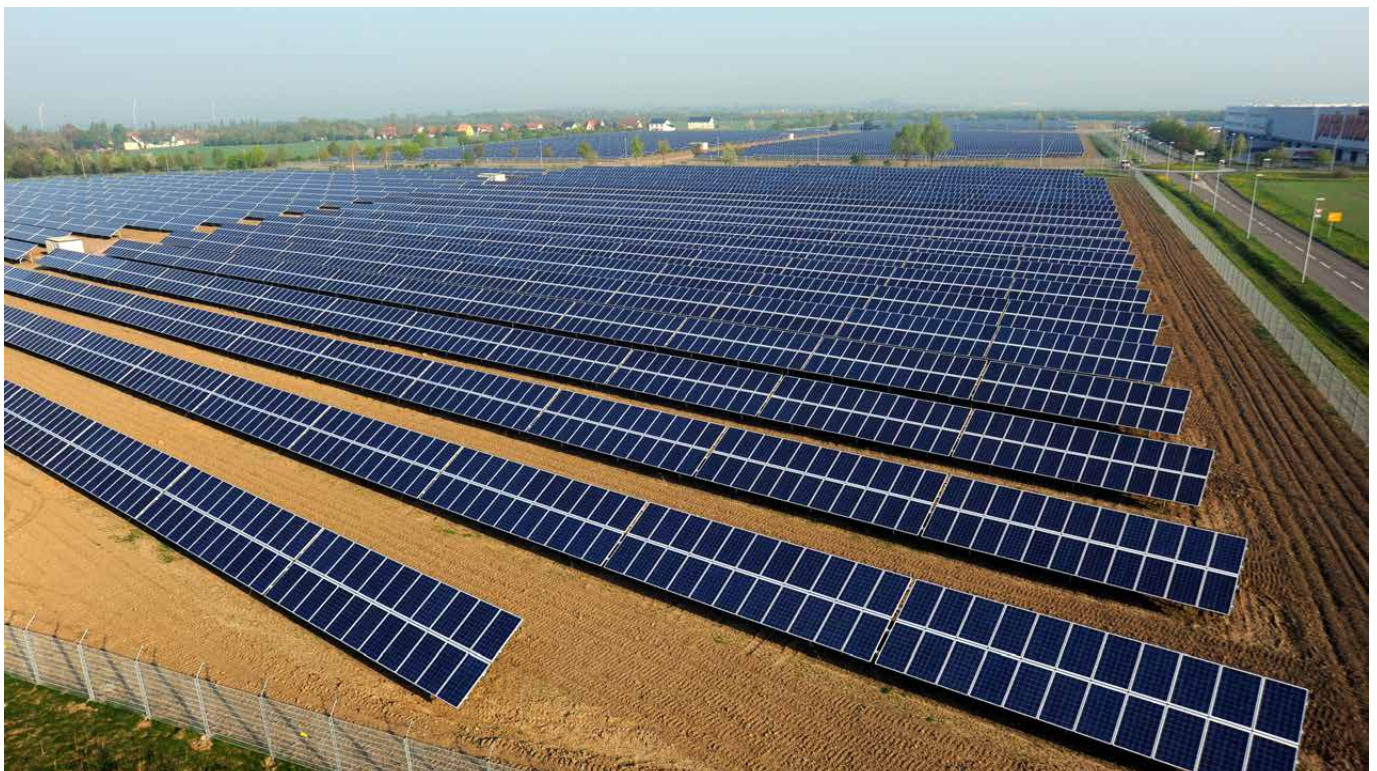
Der Solarpark Sietzsch in Sachsen-Anhalt ist die größte geplante Investition der Emittentin.
