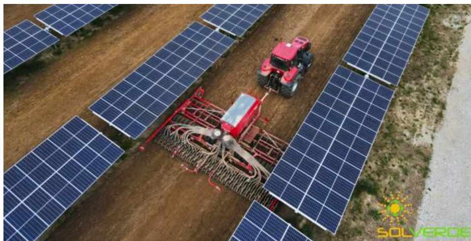
Agrar-Photovoltaik-Anlage der Solverde Energiegenossenschaft
